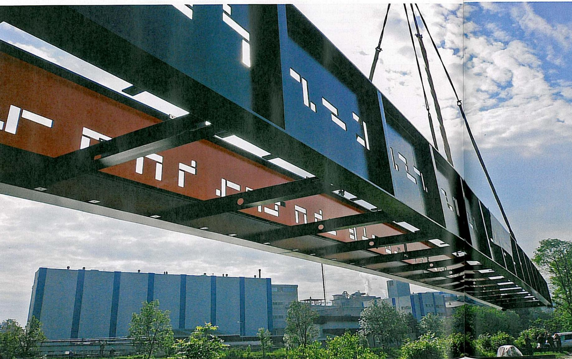
Nach der Fertigmontage am rechten Flussufer wurde der Steg von einem Schwerlastkran auf die Widerlager gesetzt.
